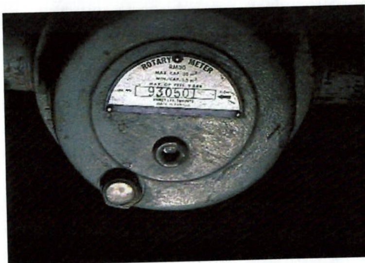
Figura 50 – Foto do medidor com capacidade de 1,5m³ a 30,0 m³.
